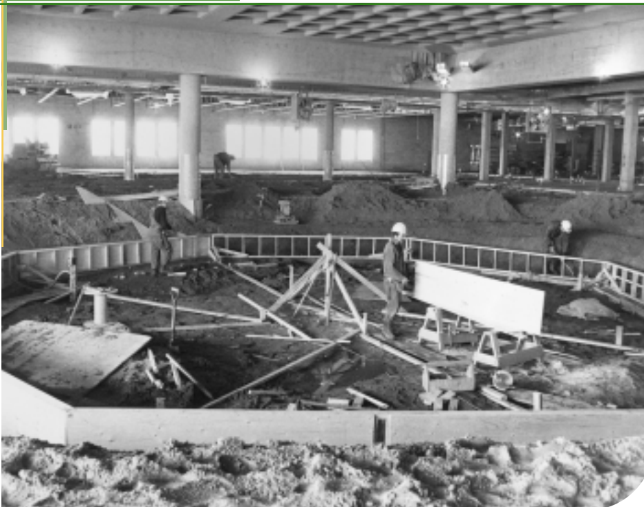
À la suite du rapport Parent, les commissions scolaires ont fait construire des dizaines de polyvalentes partout au Québec. La polyvalente le Triolet, dont on voit ici l'Agora en chantier, a été bâtie dans cette vaste opération de construction.
