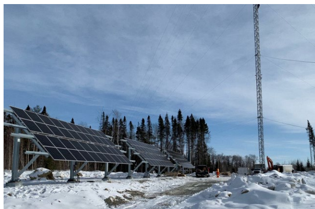
La tour de télécommunication située à Dorval Lodge dans la réserve faunique La Vérendrye, en Abitibi-Témiscamingue, alimentée par des panneaux photovoltaïques dans le cadre de ce projet. Photos fournies
