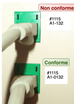
Figure 2 - Exemple d'identification de prise murale conforme et non conforme
