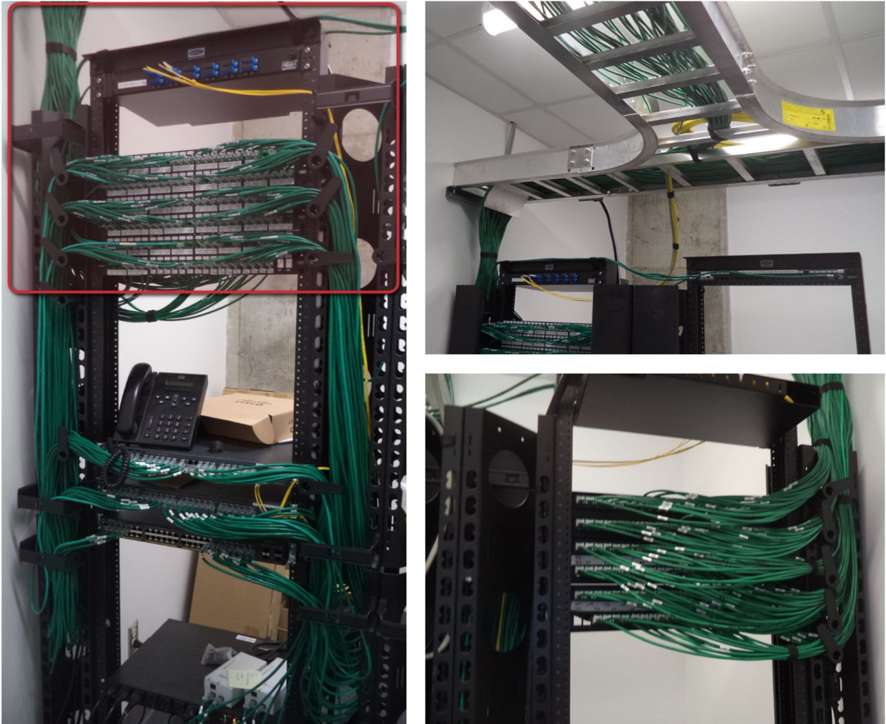
Figure 4 - Exemple d'un satellite qui respecte les standards en vigueur
