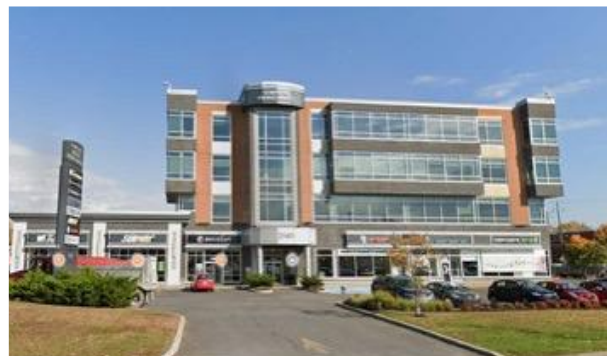
Site Montérégie, Pavillon Jean-Marc Lepage
