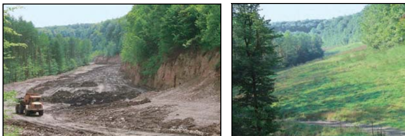
Figure 3.5 Illustrations de la mine de charbon avant les travaux et une fois remblayée. Tirée de COAST and PDEP (2006, p.1).
