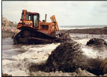
Figure 3.10 Recharge de plage à San Diego, aux Etats-Unis. Tirée de GLDD (2002, p.6)
