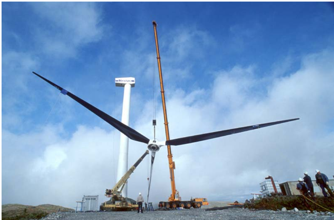
Figure 4.2 Installation de la deuxième éolienne à Haeckel Hill, Yukon
