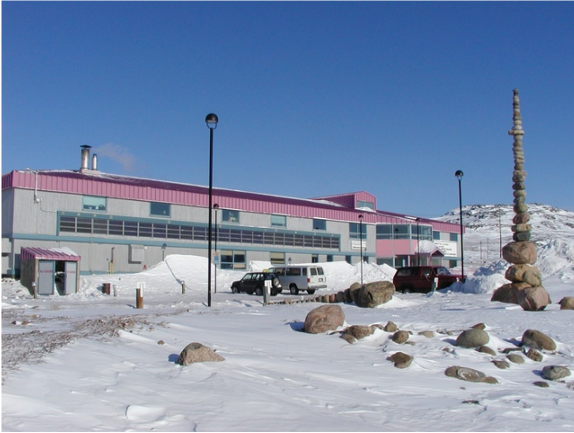
Figure 3.3 Panneaux solaires installés sur le Nunavut Arctic College
