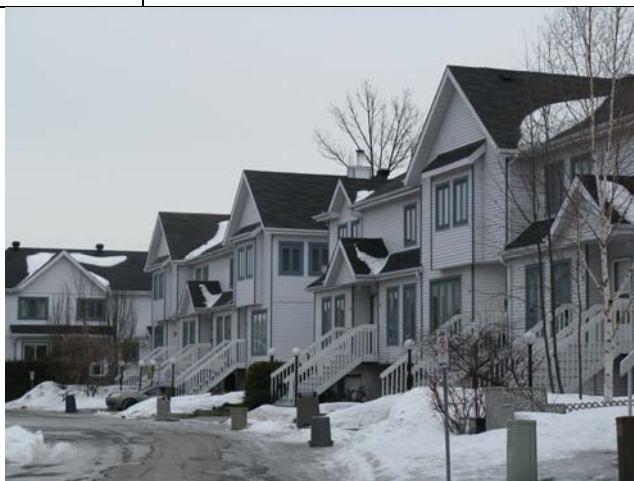
Figure 0-2: Condominiums en rangée à Hull
