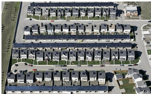
Figure 2.15 Vue aérienne de la communauté solaire de Drake Landing Okotoks CanmetÉnergie, 2009, p. 1.
