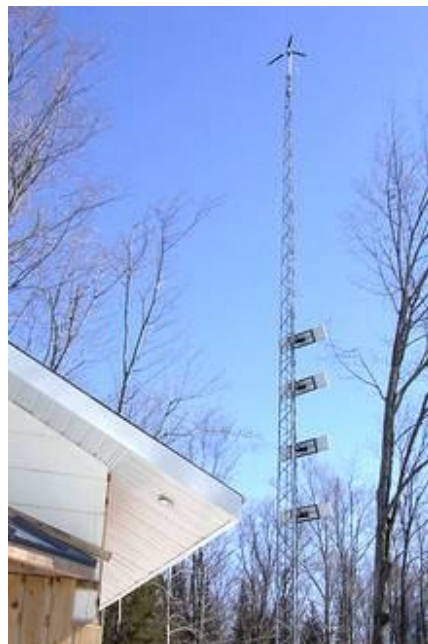
Figure 3.3 Installation d'une éolienne domestique au sommet d'une tour Guide Perrier (s. d.b)
