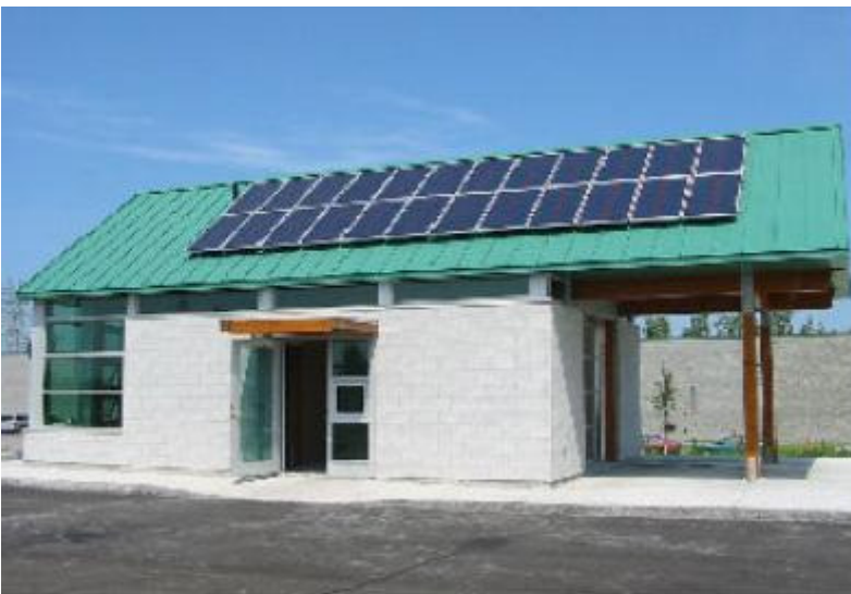
Photographie 2 : Bâtiment d'accueil écocentre de Montréal
