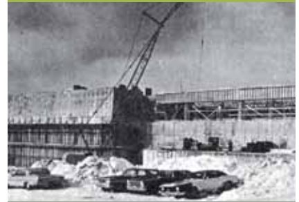
Construction de la Faculté de droit en 1971
